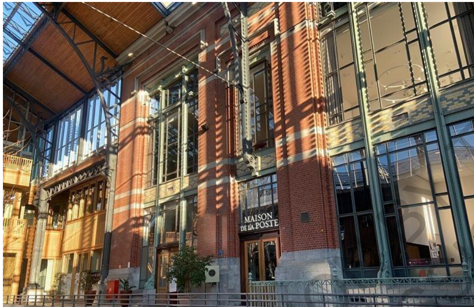
Figure 3 Maison de la Poste building
